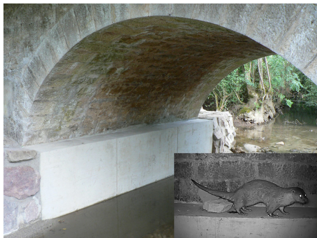
Passage à loutres sous pont sur l'Armanche à Metz-le-Comte (RD 280)
