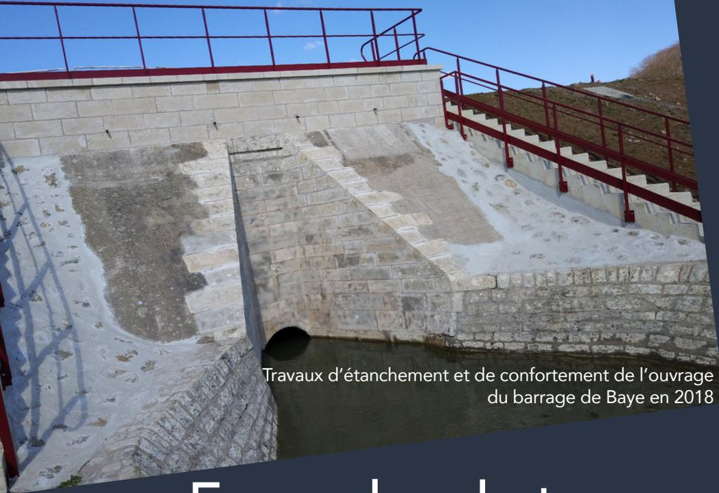
Travaux d'étanchement et de confortement de l'ouvrage du barrage de Baye en 2018
