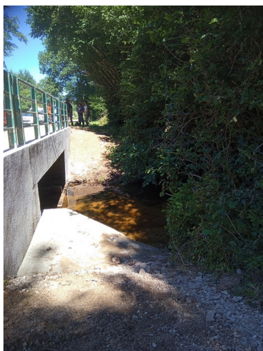
Travaux d'aménagement réalisés sur l'année 2022 en faveur de la loutre (banquettes et passerelles à Moux et Montsauche)
