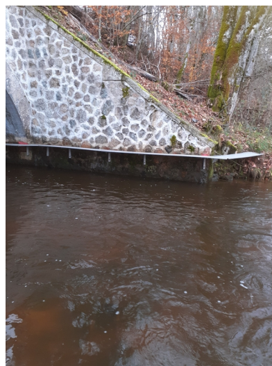
Travaux d'aménagement réalisés sur l'année 2022 en faveur de la loutre (banquettes et passerelles à Moux et Montsauche)
