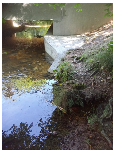
Travaux d'aménagement réalisés sur l'année 2022 en faveur de la loutre (banquettes et passerelles à Moux et Montsauche)
