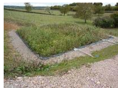
Station d'épuration par macrophytes à St-Benin d'Azy CD58
