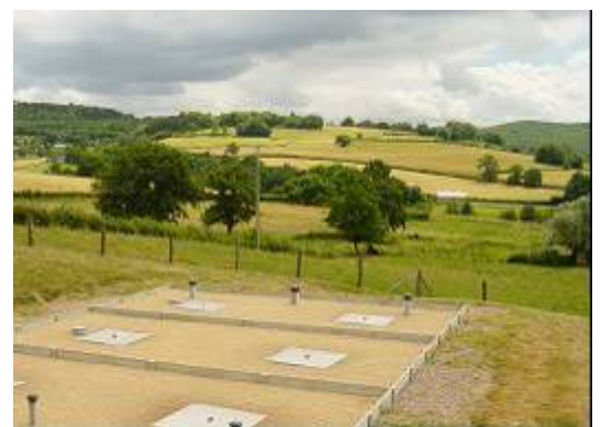
Station d'épuration de Villapourçon CD58
