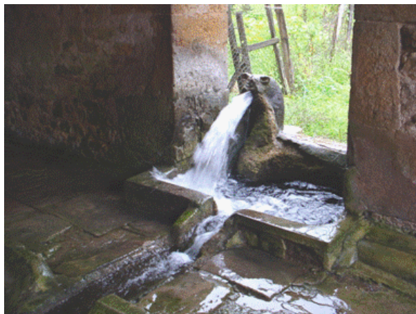
Résurgence de la nappe des calcaires du Nivernais au lavoir de Neuffontaines (CD58)
