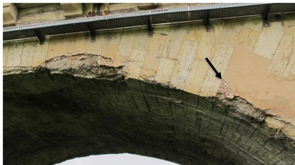
Figure 48 : réparations de la fin du XIXème siècle mêlant rocaillages de fragments de brique et enduit (photographie CTSM/INGEROP).
