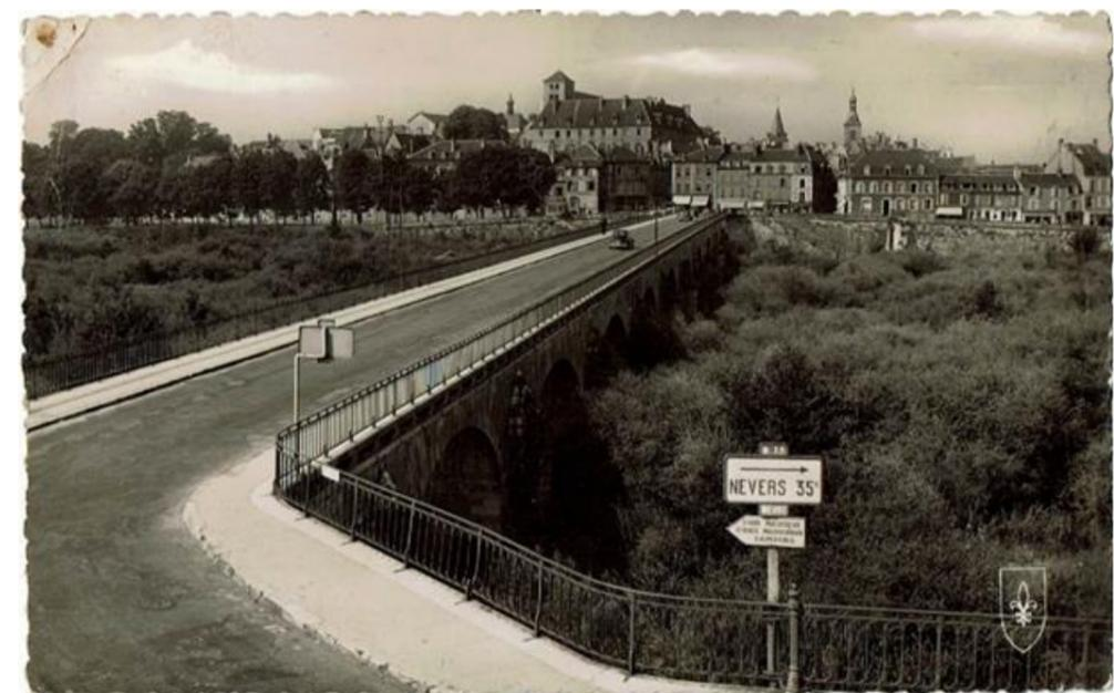
Figure 47 : vue de l'encorbellement et du quai en rive droite
