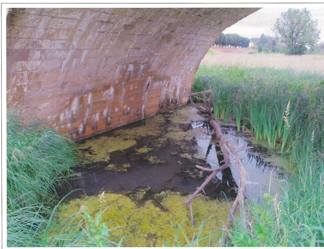
Face gauche Pile 9 -Photo 58-
