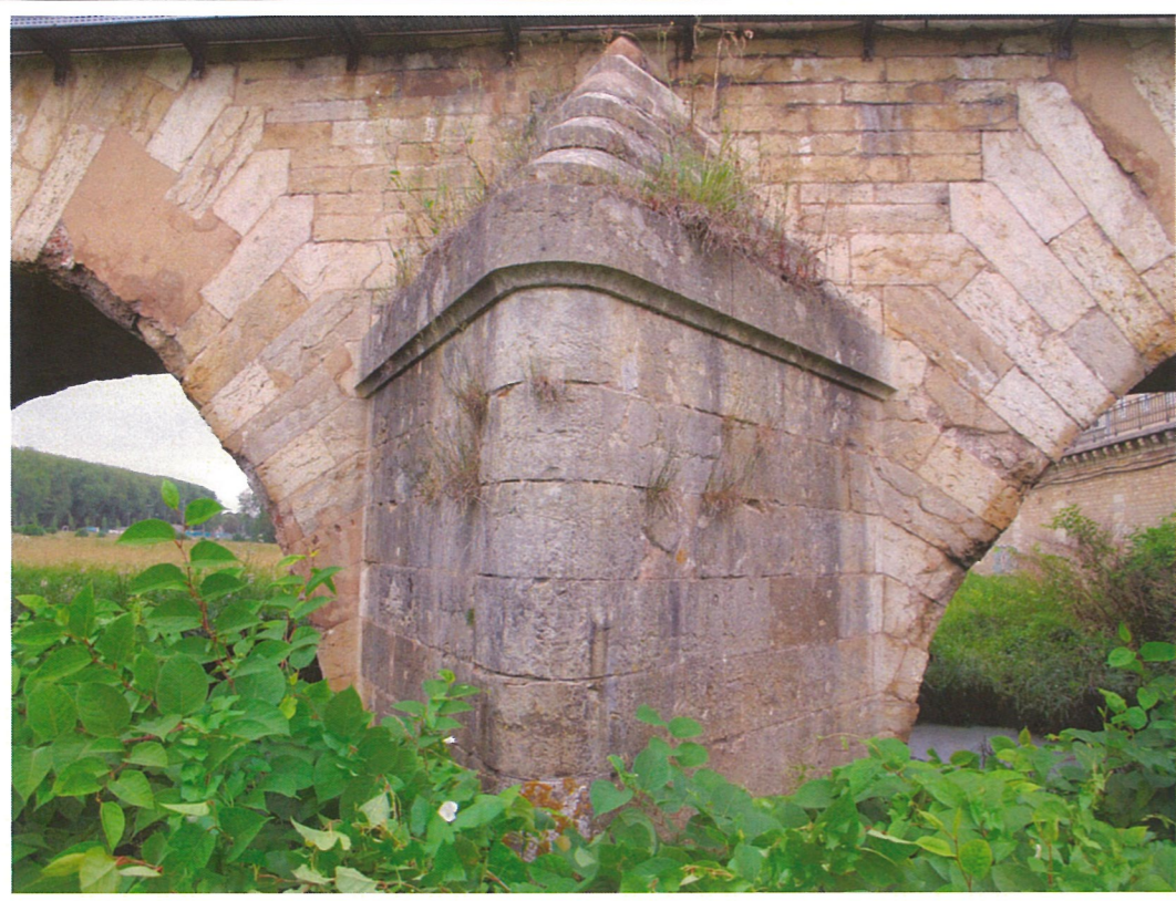
Avant bec Pile 10 -Photo 62-
