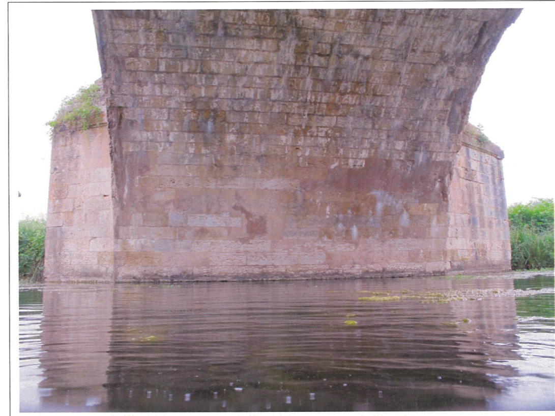
Face gauche Pile 2 -Photo 15-
