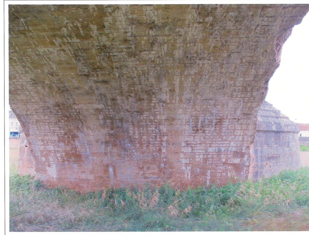
Face gauche Pile 7 -Photo 45-
