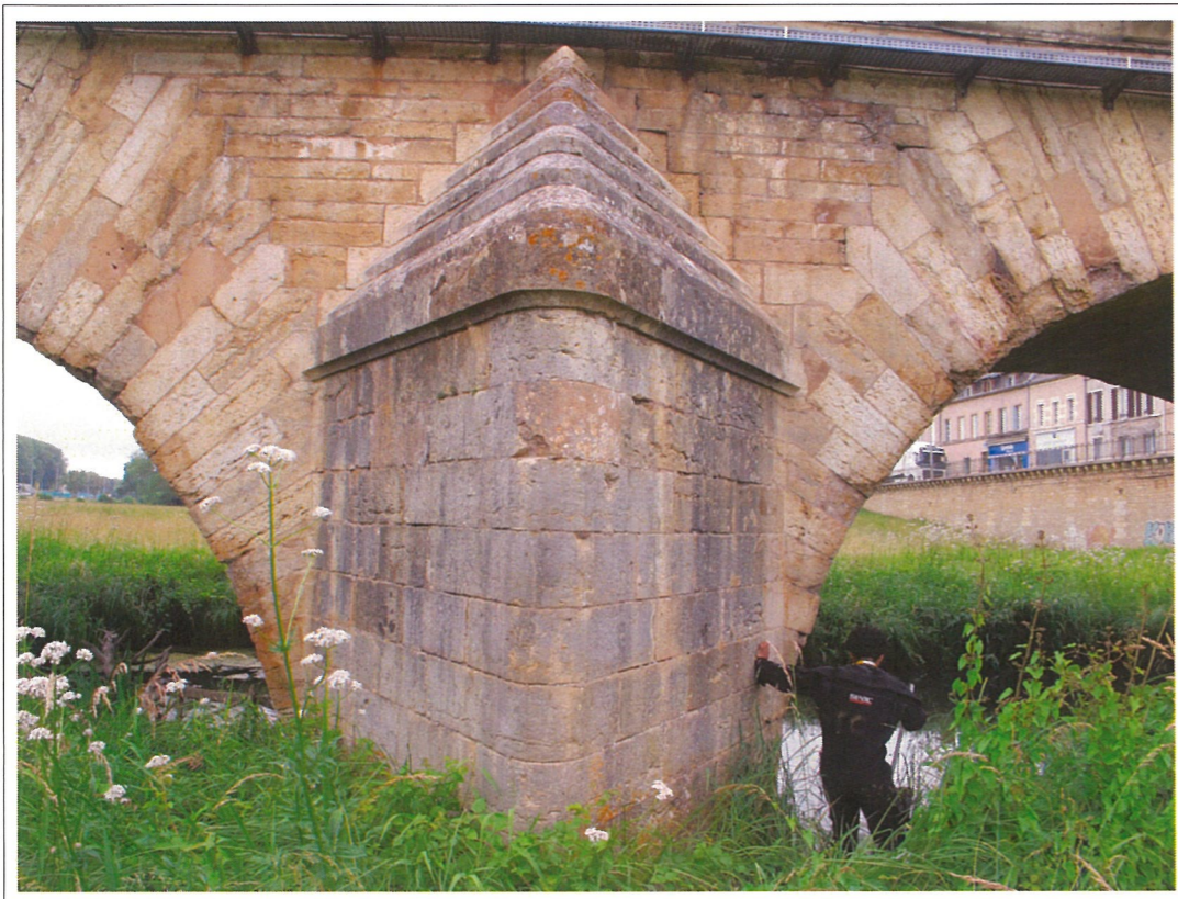
Avant bec Pile 9 -Photo 56-
