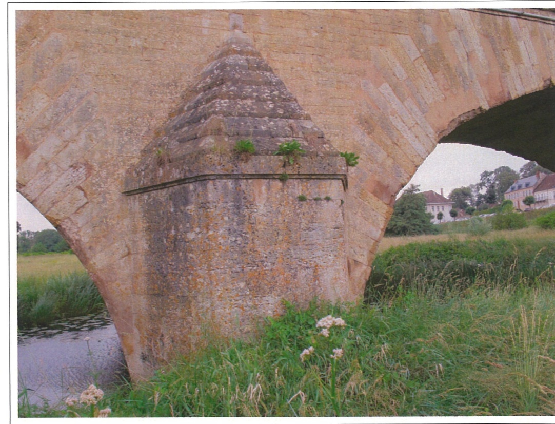
Arrière bec Pile 4 -Photo 27-
