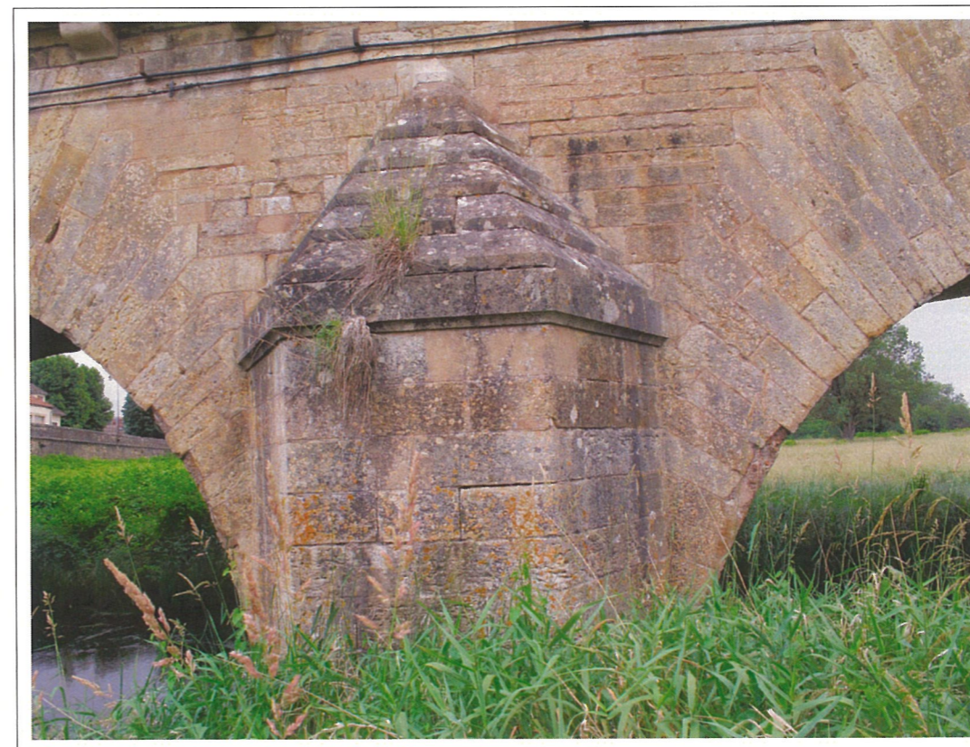
Arrière bec Pile 9 -Photo 59-
