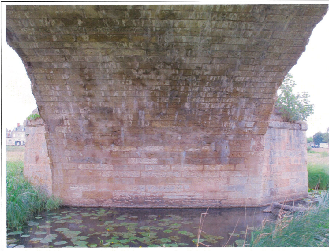
Face gauche Pile 4 -Photo 26-
