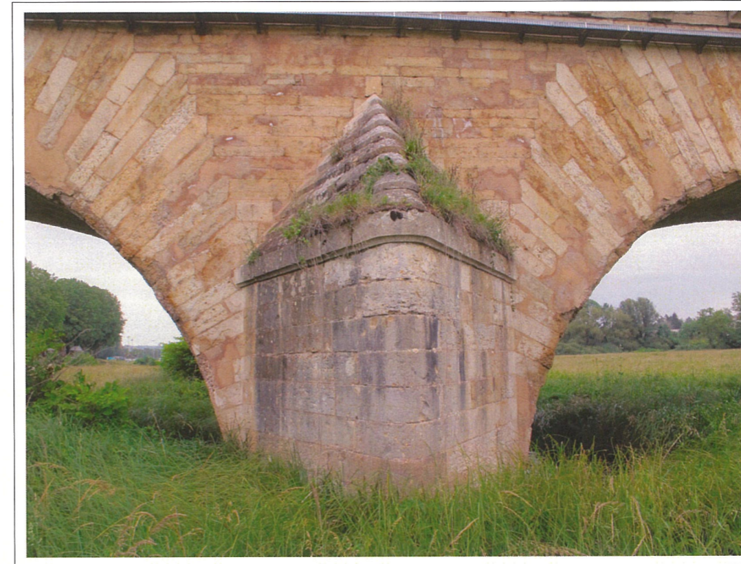
Avant bec Pile 3 -Photo 19-
