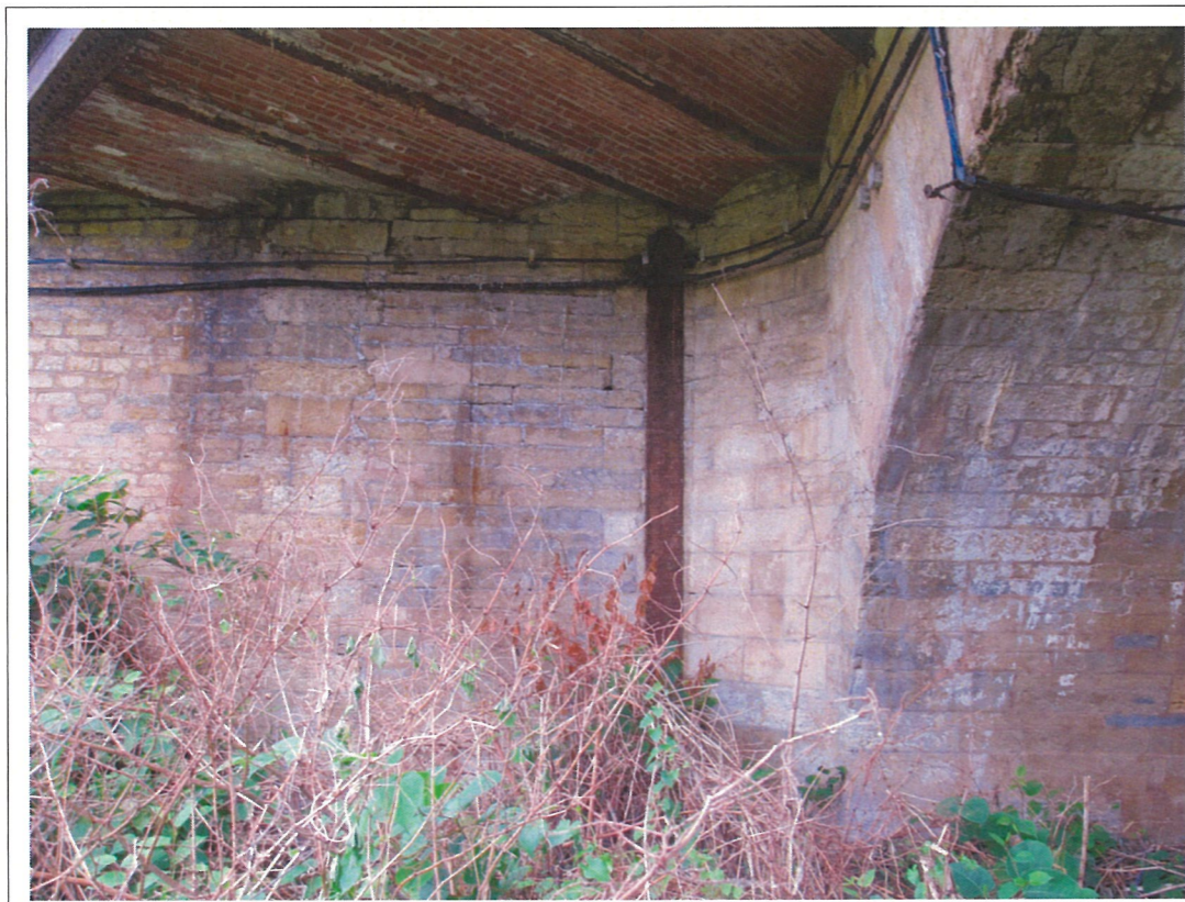
Mur retour aval de la culée rive droite -Photo 72-
