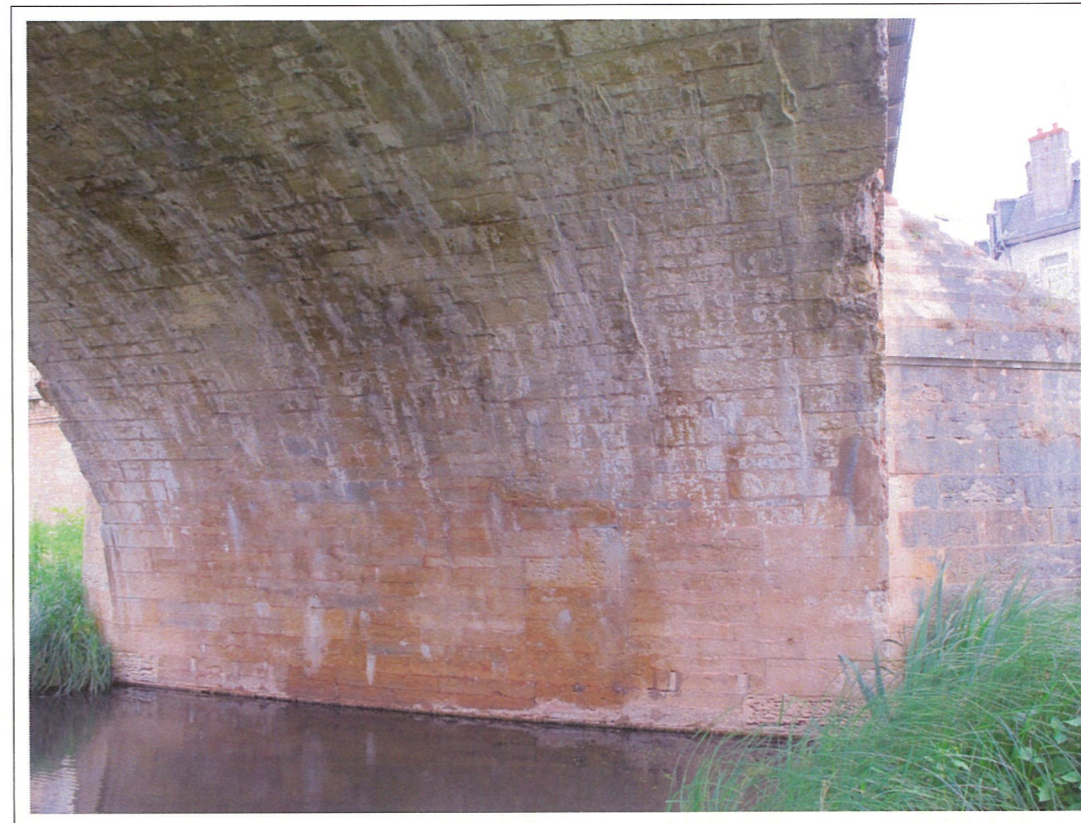
Face gauche Pile 10 -Photo 63-
