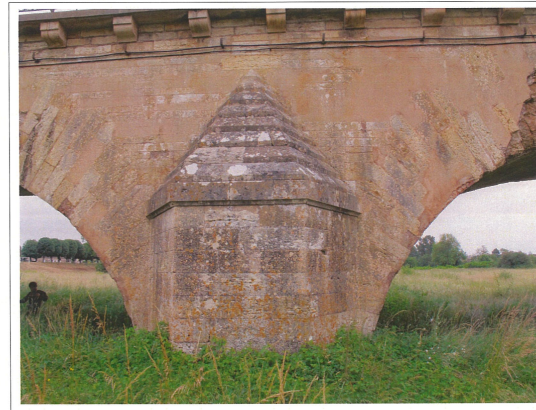
Arrière bec Pile 7 -Photo 47-
