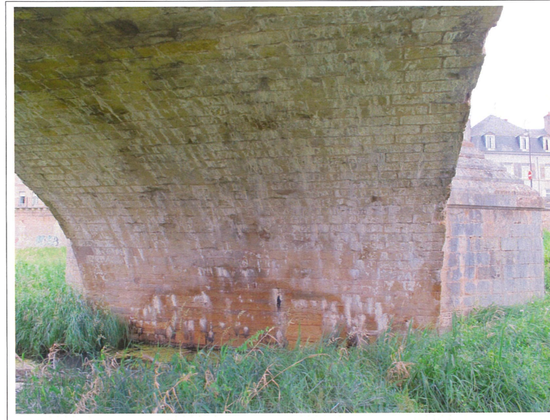
Face gauche Pile 9 -Photo 57-
