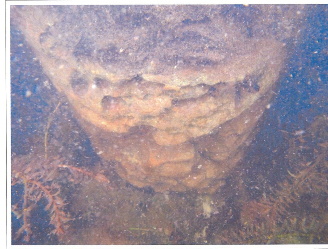
Avant bec Pile 1 Vue sous-marine -Photo 9-
