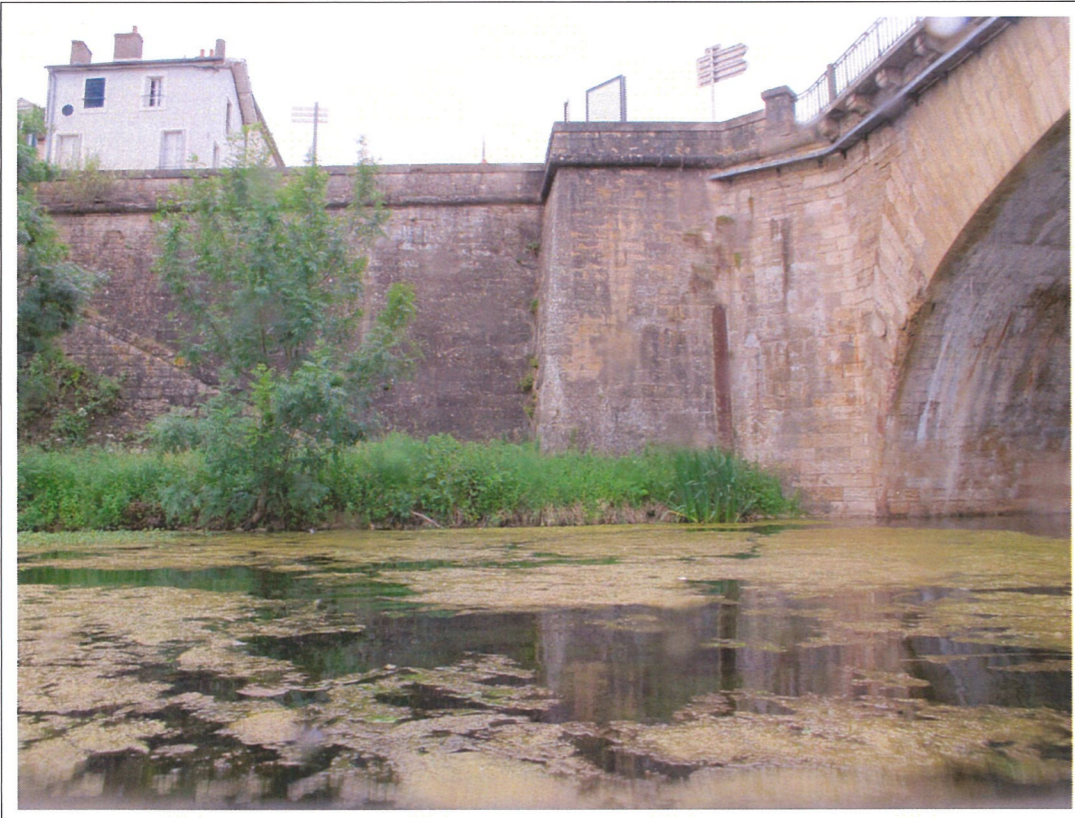
Mur retour aval de la culée rive gauche -Photo 2-
