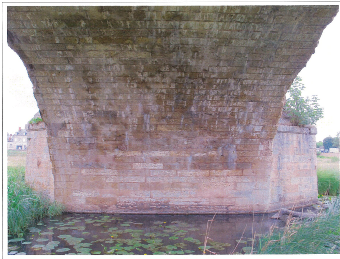
Face gauche Pile 4 -Photo 26-
