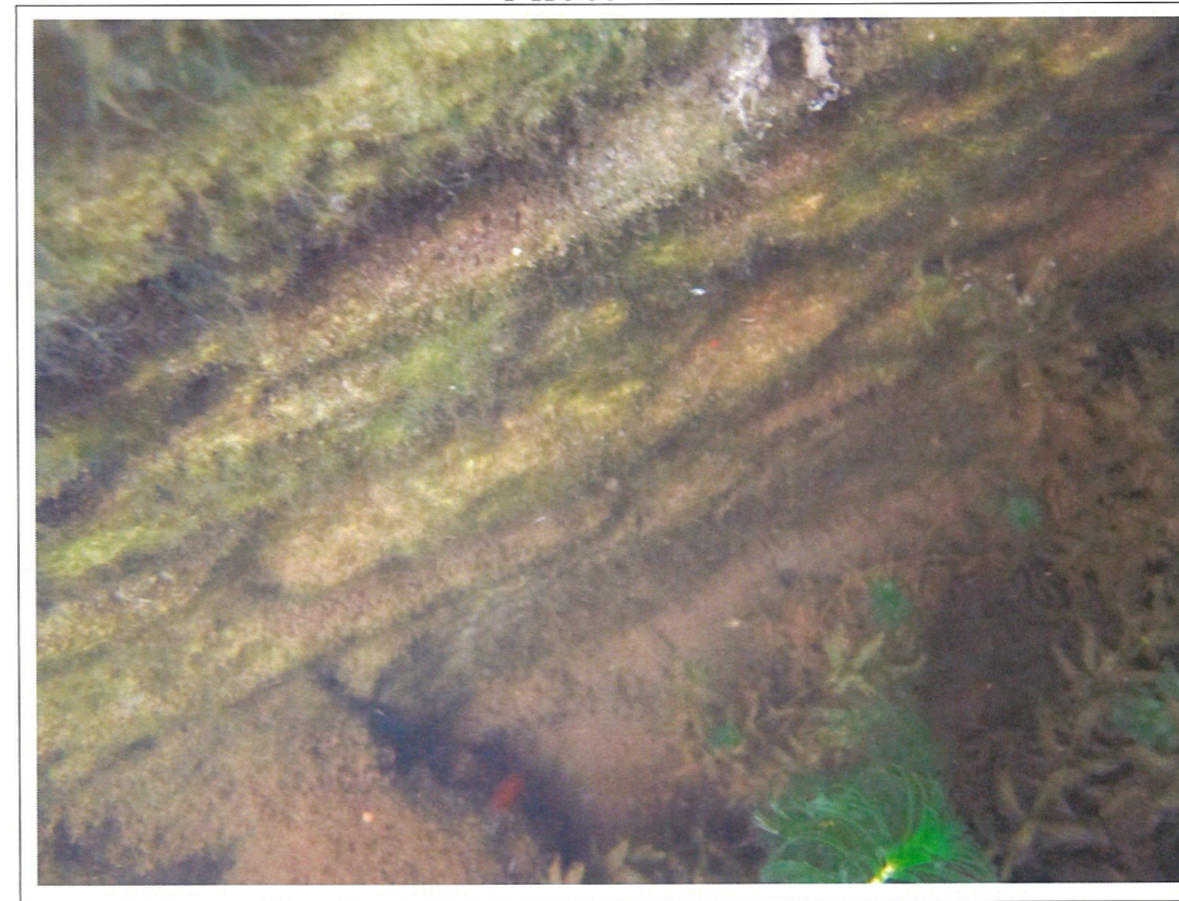
Culée rive gauche Vue sous-marine -Photo 5-
