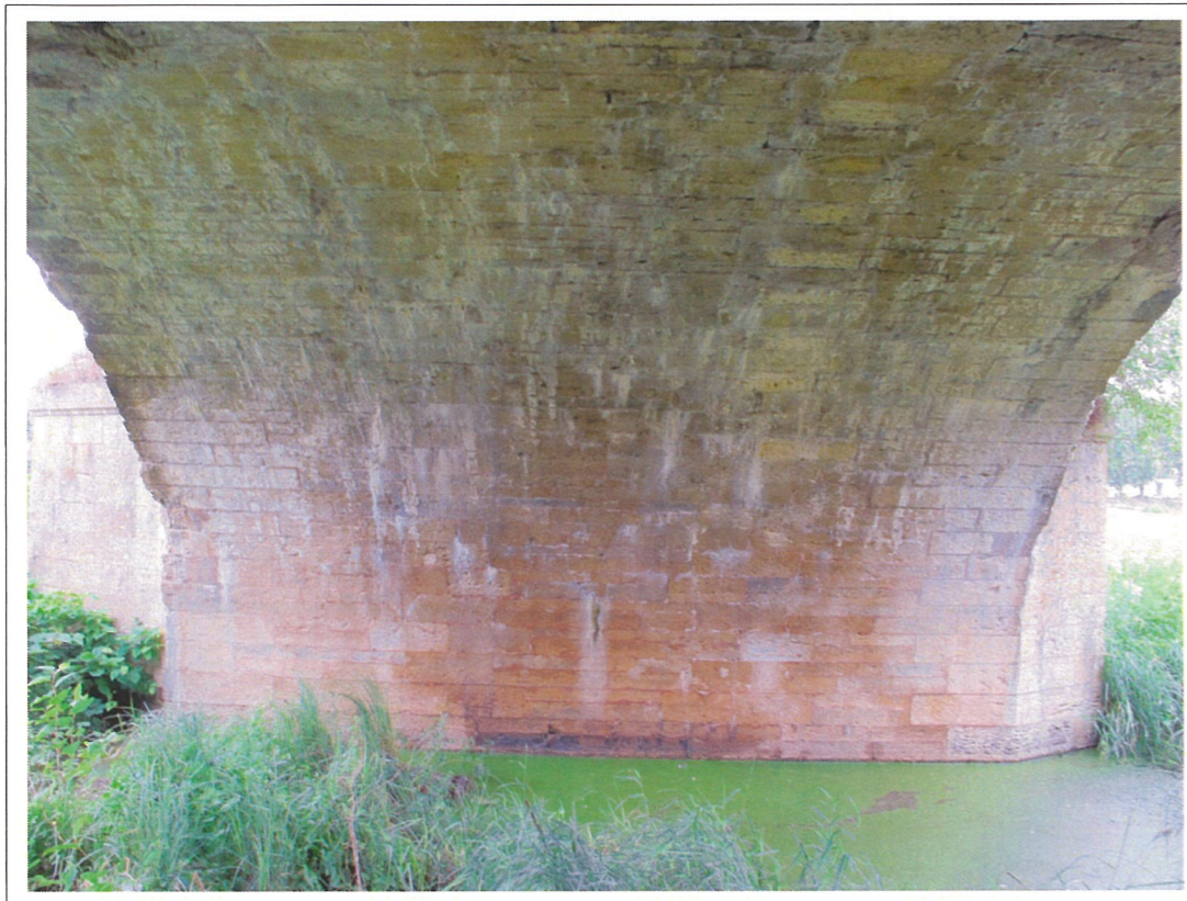
Face gauche Pile 10 -Photo 66-
