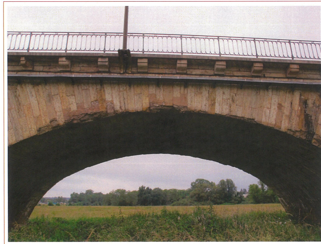
Tympan amont en passe 5 Epaufures du bandeau -Photo 37-
