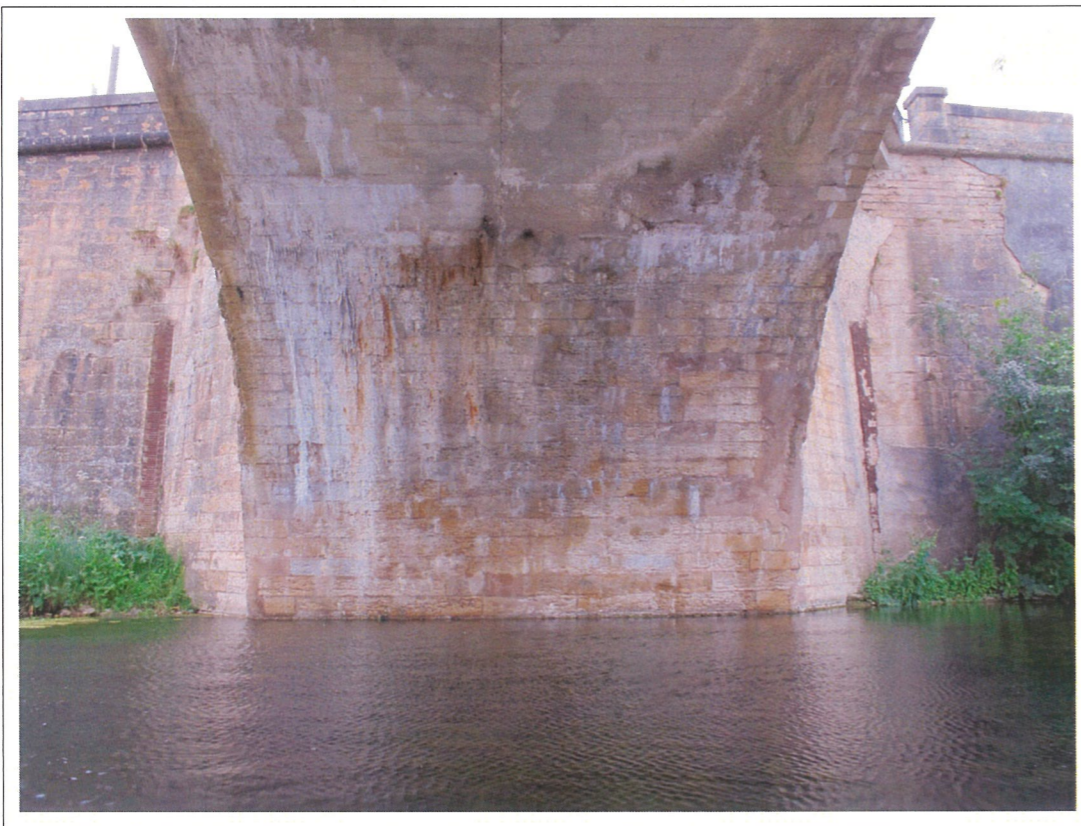
Culée rive gauche -Photo 4-
