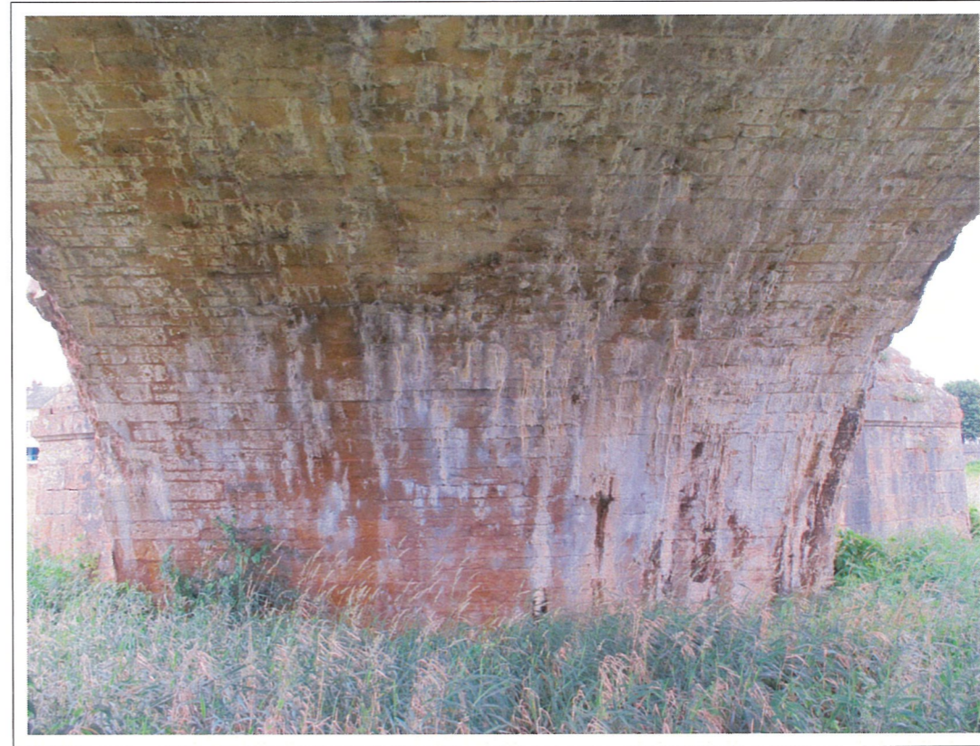
Face gauche Pile 6 -Photo 39-
