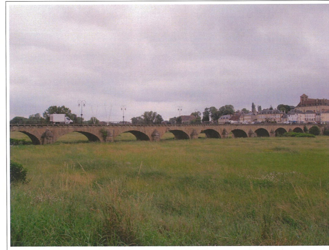
Vue aval -Photo 73-
