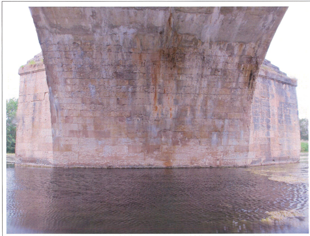
Face gauche Pile 1 -Photo 10-
