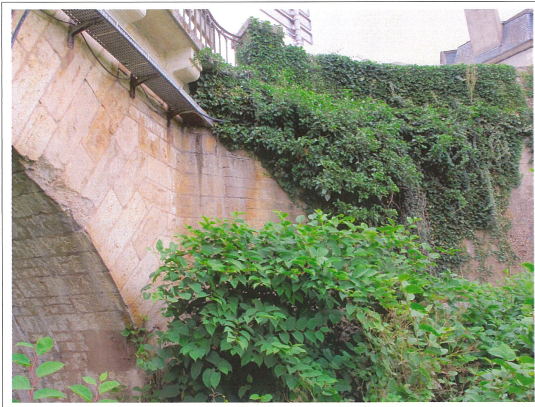
Mur retour amont de la culée rive droite -Photo 70-
