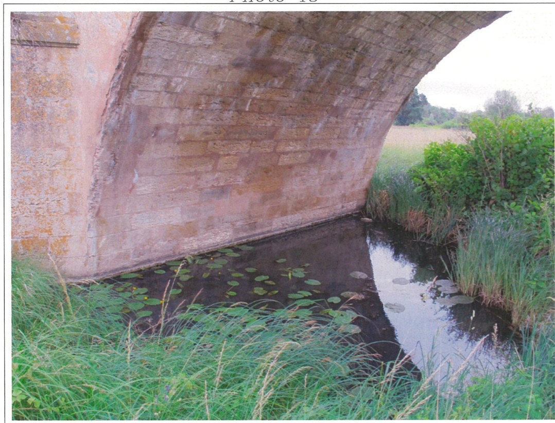
Face gauche Pile 3 -Photo 20-
