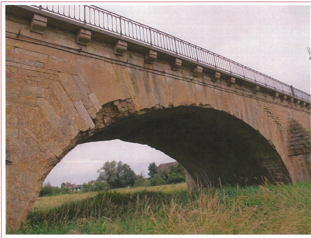
Tympan aval en passe 5 Epaufures du bandeau -Photo 40-
