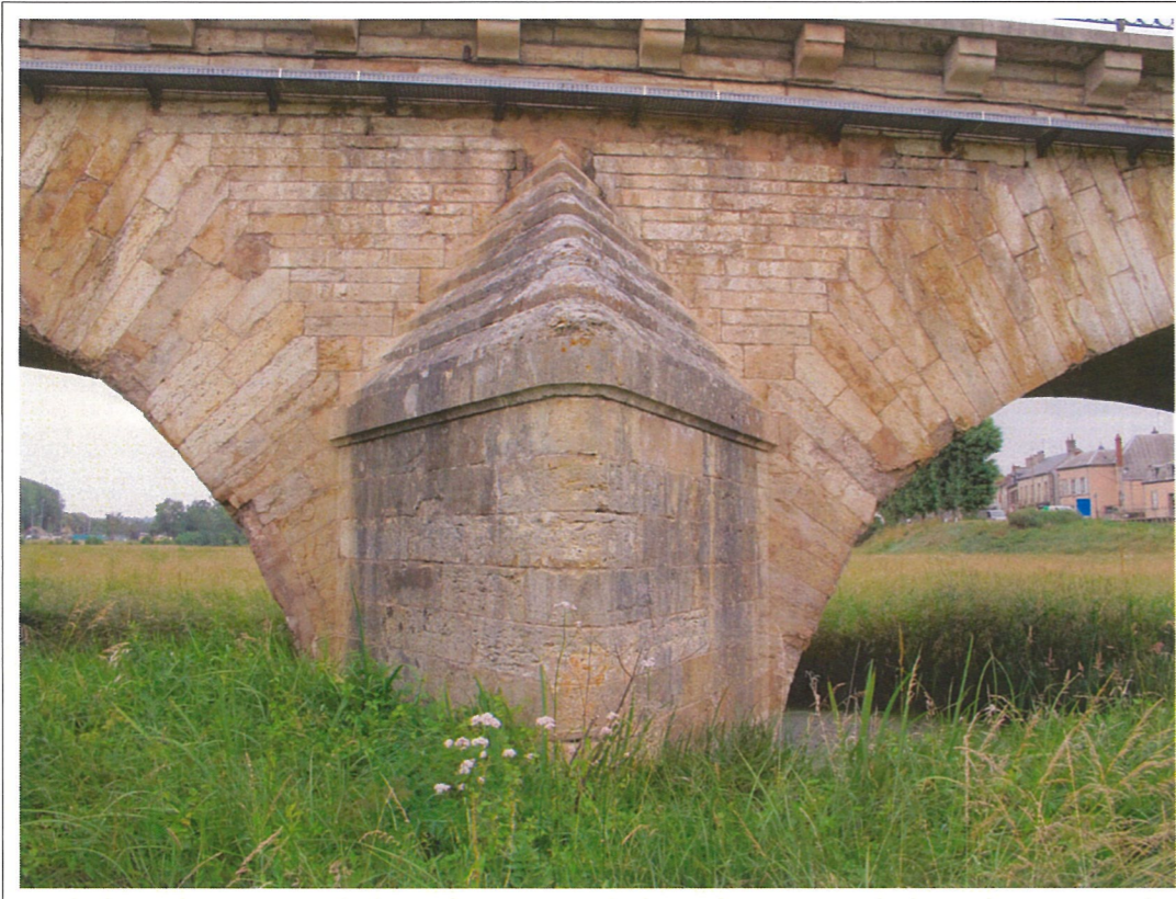
Avant bec Pile 7 -Photo 44-
