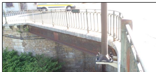
Figure 2 : Photo d'un élargissement
