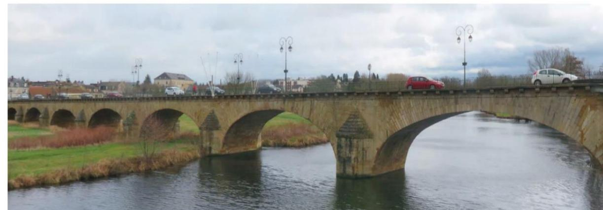
Figure 36 : Photomontage avec le doublement de l'ouvrage – solution parement pierres sur l'intrados du nouvel ouvrage
