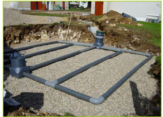
Chantier de réalisation d'un système de traitement - filtre à sable vertical non drainé.
