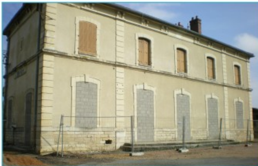
Photo 1 : Vue de la partie Sud du bâtiment principal de la gare
